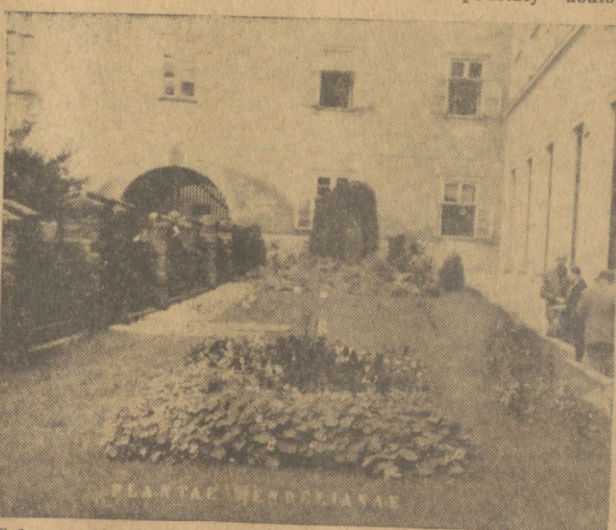
Tak vypadá Mendlova zahrádka dnes po úpravách v bývalém augustiniánském klášteře na Starém Brně.
